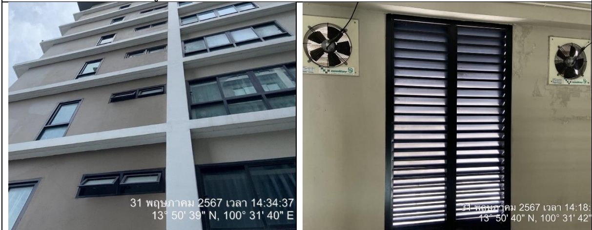
รูปที่ 2-4 ระบบระบายอากาศของโครงการ
